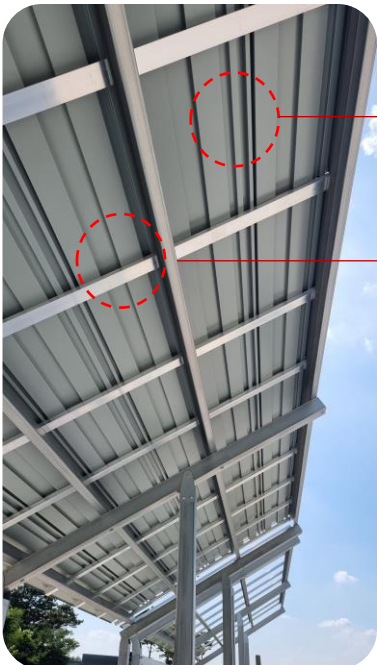
[강판 절곡 구조와 PV 모듈을 일체 접합하고, 알루미늄 고정 스테드로 견고하게 체결한 구조]
